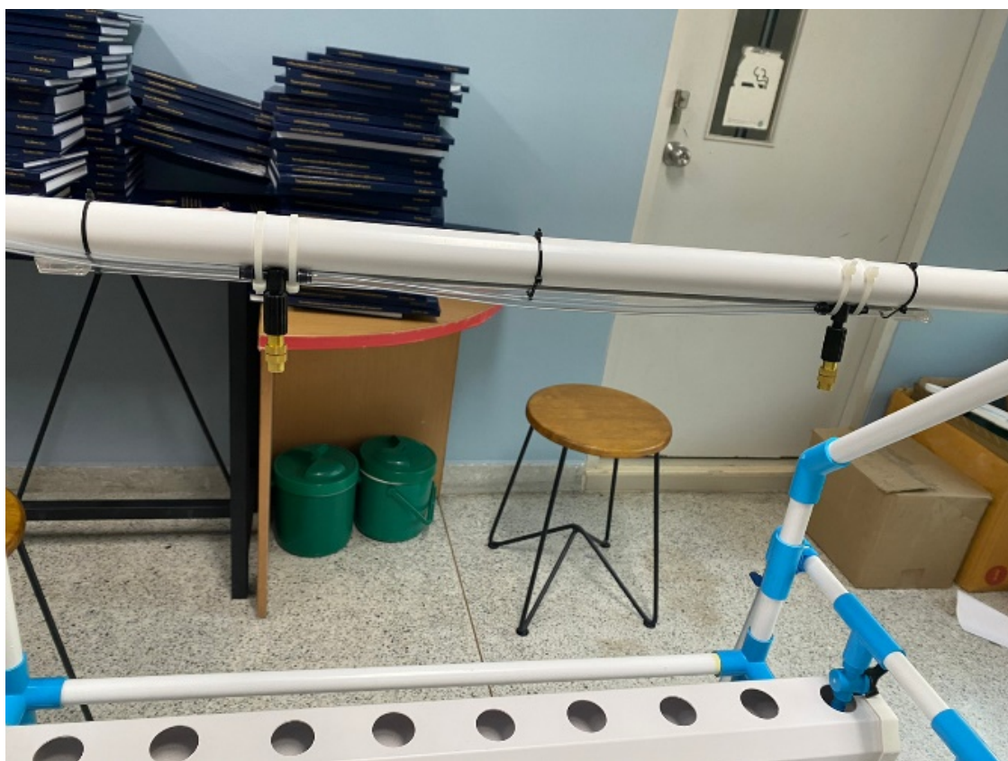
รูปที่ 4.4 ติดตั้ง อุปกรณ์พ่นน้ำ
